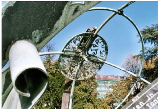
Detalle del anclaje superior del gnomon
