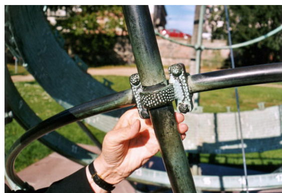
Detalle de una de las bridas de sujeción.
