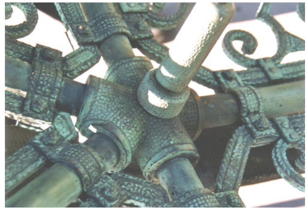
Detalle anclaje inferior del gnomon
