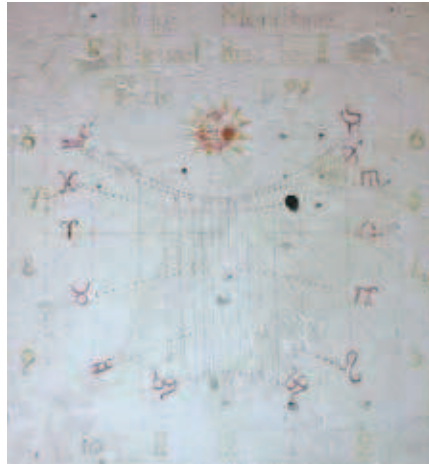
Fig. 15.- Estat del Relox Meridional després de la neteja.
